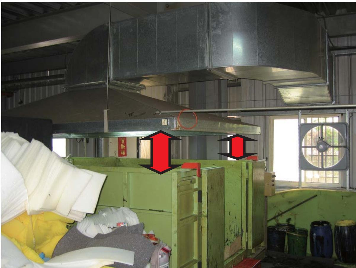
說明：外裝型氣罩應儘量接近有機溶劑發生源，避免逸散。
