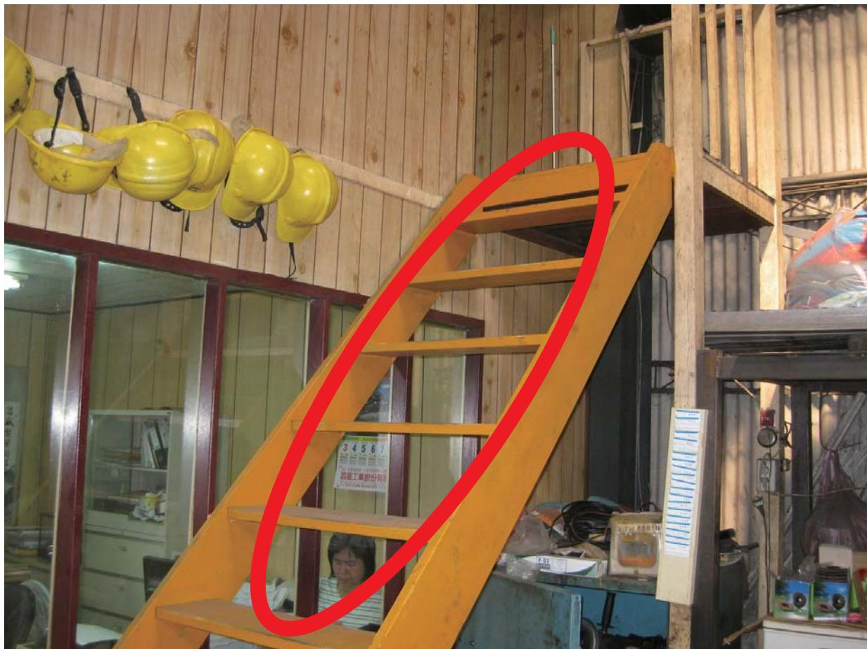
說明：高差超過1.5公尺以上之作業場所，應設置能使勞工安全上下之設備。（職業安全衛生設施規則第228條）
