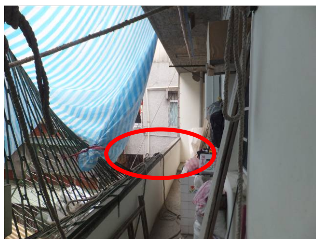
說明：發生災害現場。（紅色圓圈處為罹災者作業位置）
