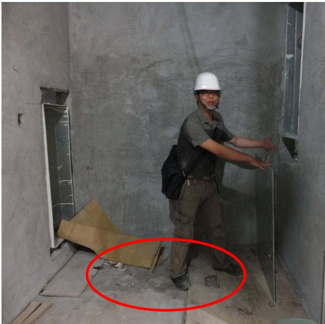
說明：災害發生現場玻璃堆置作業模擬（紅色圓圈處為玻璃倒塌位置）。
