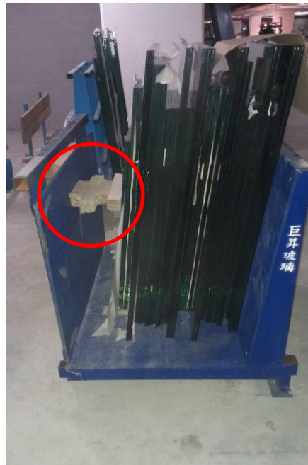
說明：玻璃堆置應使用玻璃架（紅色圓圈處為玻璃固定紙管）
