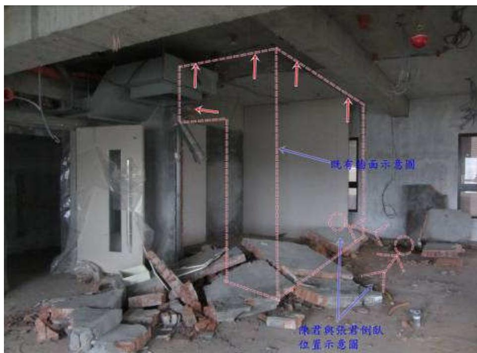
說明：既有磚牆拆除作業現場，陳君與張君倒臥位置示意圖，紅色箭頭處為磚牆結構物斷裂處。
