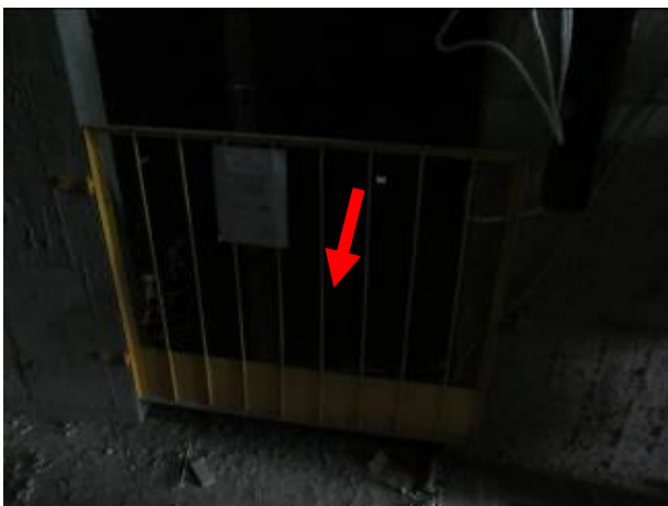
圖一、事發現場之地上 1 樓電梯井。(箭頭為作業位置)
