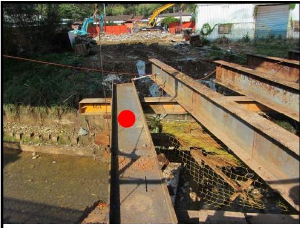
圖一、職災現場情況。紅點處即為罹災者作業位置，其上方紅色繩索即為安全母索。
