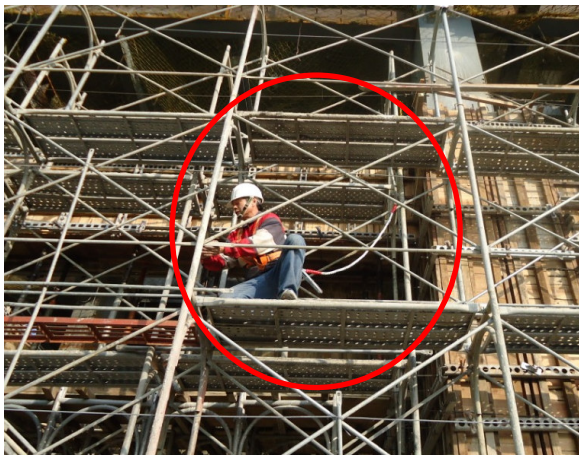
圖三、勞工從事高處作業應確實使用安全帶。
