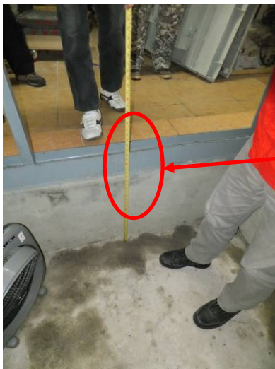
說明 | 地上 1 樓電梯坑蔡員墜落處(面朝下、頭朝內)，深度約 67 公分。
