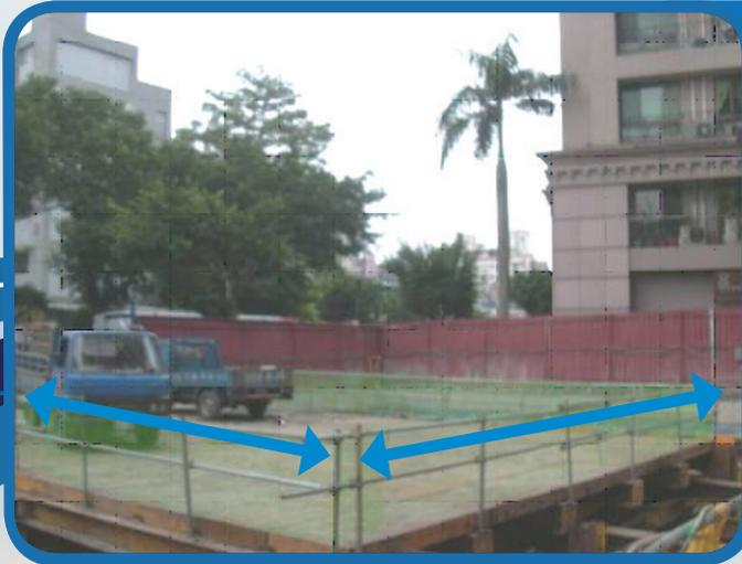
施工構臺周邊開口已設置護欄。
