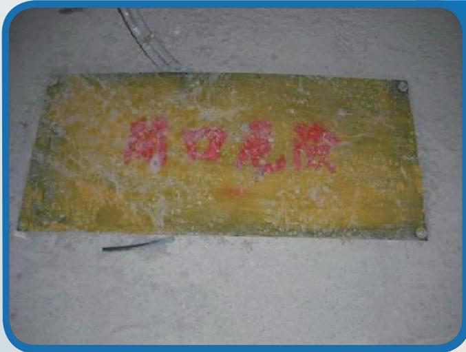
臨時性開口已設置符合規定之護蓋（表面漆以黃色及書寫警告訊息）。
