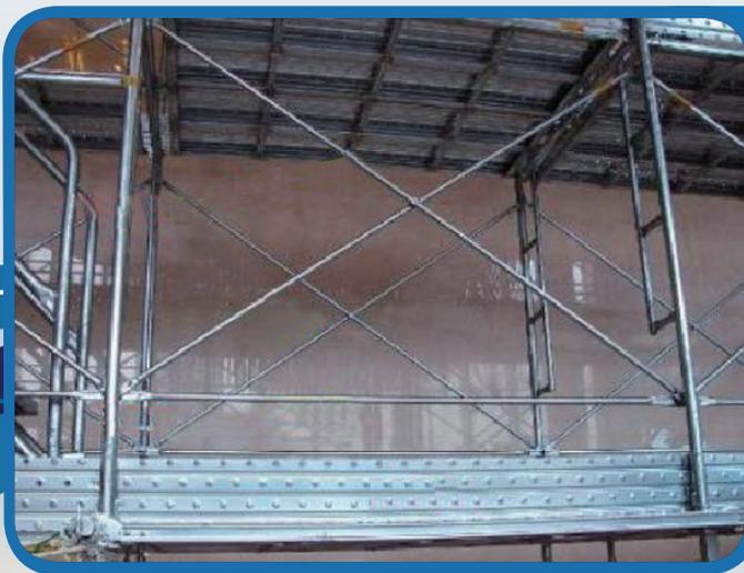
施工架兩側已設置交叉拉桿、下拉桿，與腳趾板。
