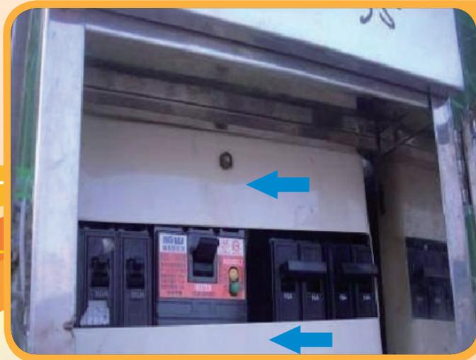
電源箱已配置中隔板。
