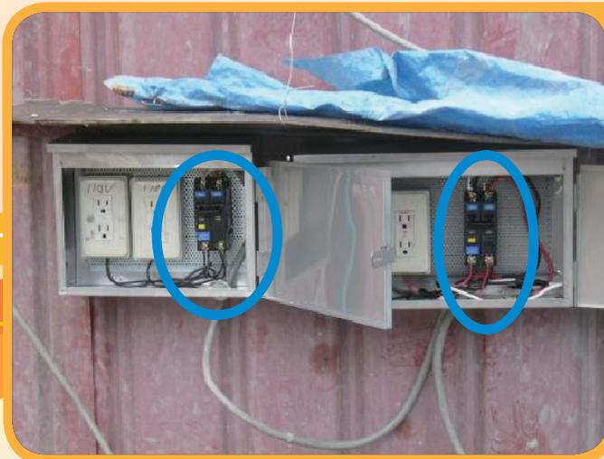
臨時用電設備已設置漏電斷路器。
