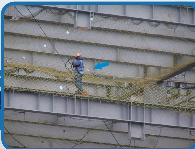
已設置安全母索並使勞工確實使用安全帶。
