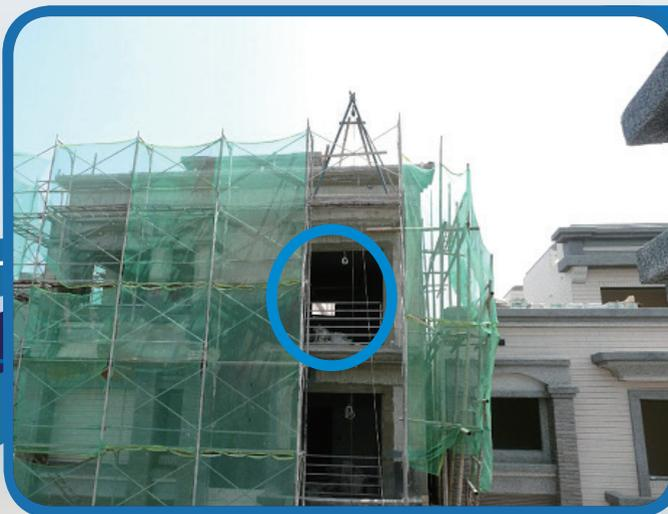
外牆吊料口已設置護欄。
