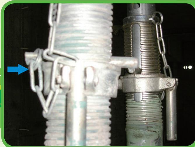
可調式鋼管支柱以制式金屬配件調整高度。
