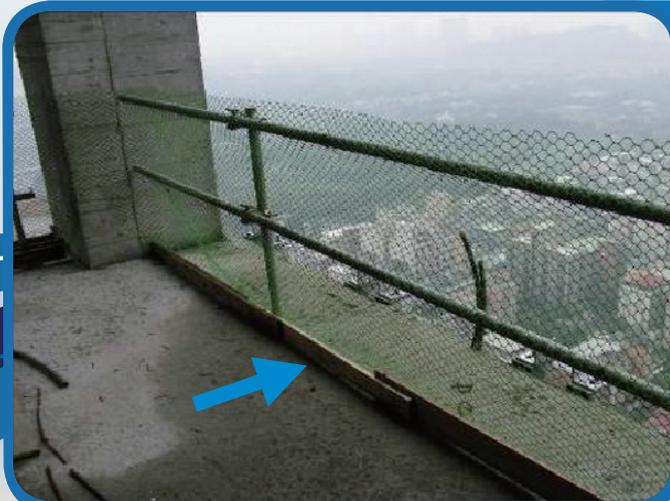
開口邊緣護欄已設置腳趾板。
