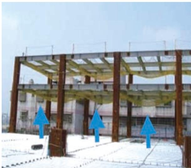
**說明** 鋼構樓板開口應鋪設安全網等防墜設備。
