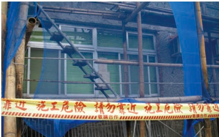
**說明** 勞工從事高度2公尺以上之竹架作業，雇主應設置安全上下設備並裝設護欄，或使勞工確實使用安全帶等防墜措施（改善參考照片）。
