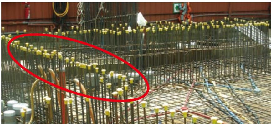
**說明** 暴露於工作場所之鋼筋，應加裝護套等防護設施。
