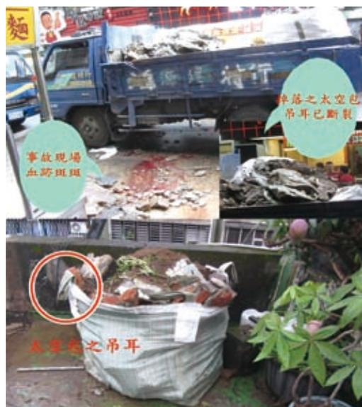
**說明** 吊耳跟吊掛物之結合方式，應能承受所吊物體之整體重量，使其不致脫落或斷裂。
