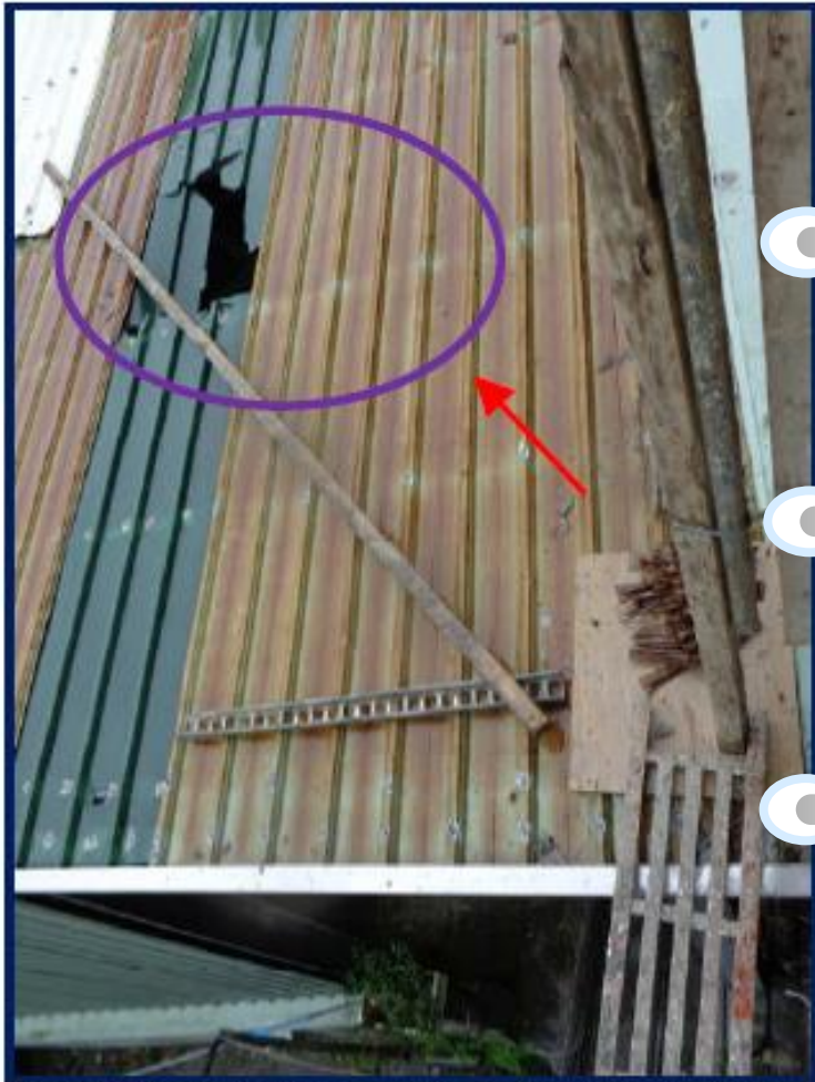
說明：箭頭處為勞工踏穿屋頂採光罩處。
