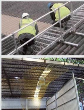
於石綿板、鐵皮板、瓦、木板、茅草、塑膠等材料構築之屋頂從事作業，應設置適當強度且寬度在三十公分以上之踏板或裝設安全網。
