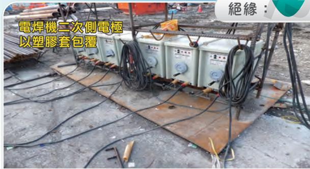
電焊機二次側電極以塑膠套包覆
