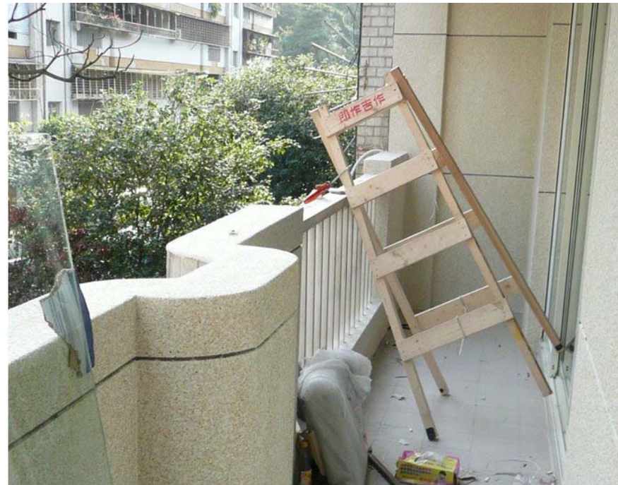
使用合梯作業墜落陽台外職災
