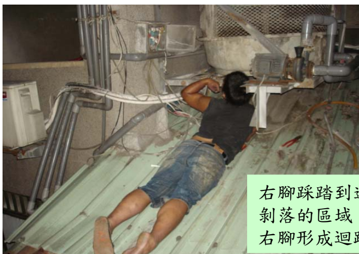
冷卻水塔，左側閘刀開關， 及下方鐵架均帶電。
