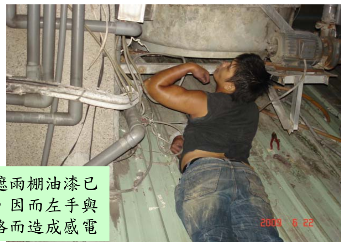
測量馬達以遮雨棚為接 地之漏電電壓在 165.6~166.7V之間
