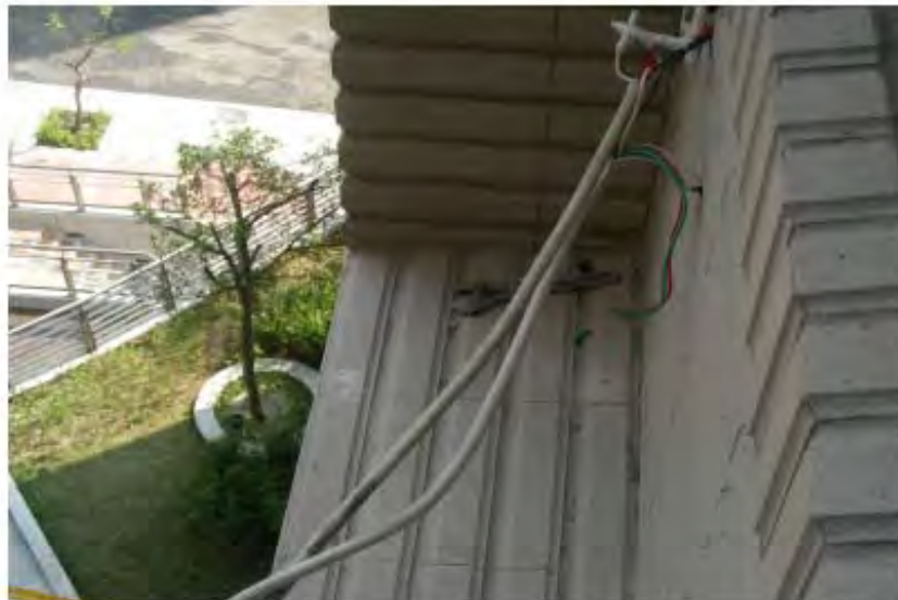
事故現場5樓施工平台。
