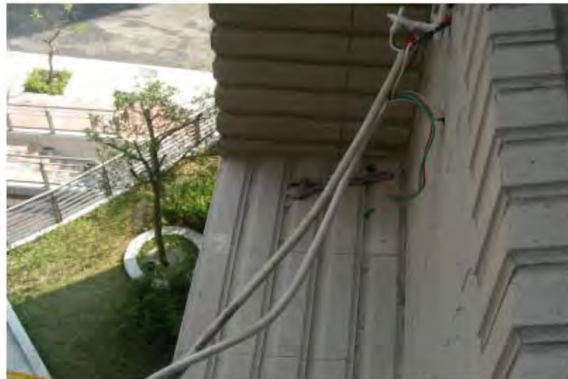
事故現場5樓施工平台。
