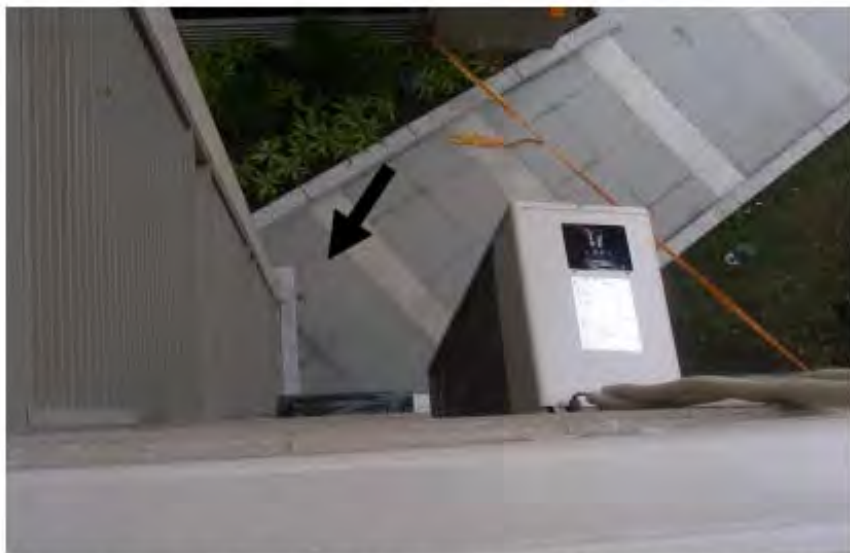
事故現場俯視圖，以箭號標示罹災者墜落地點。
