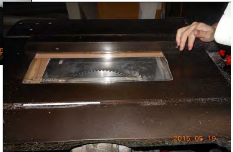
Chú thích: Bánh đĩa cưa tròn chưa được lắp đặt công cụ phòng ngừa tiếp xúc với răng cưa. 說明：裁板機圓盤鋸未設置鋸齒接觸預防裝置。
