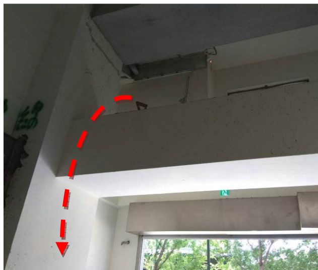
說明：開口位置設置護欄及安全網。
