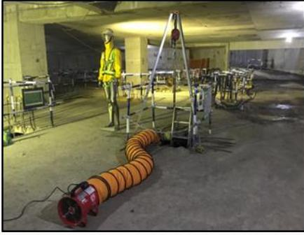
①設腳架、防墜器、上下及通風設備
