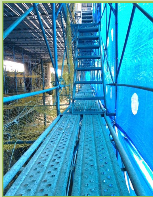
After 施工架未放鋼筋
