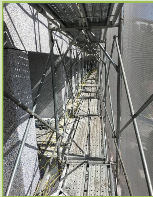
After 施工架高處清除物料
