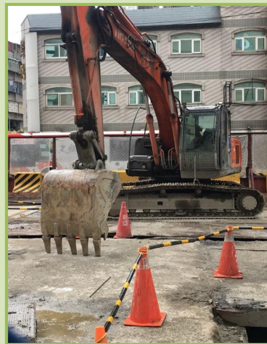
After 設置擋風玻璃
