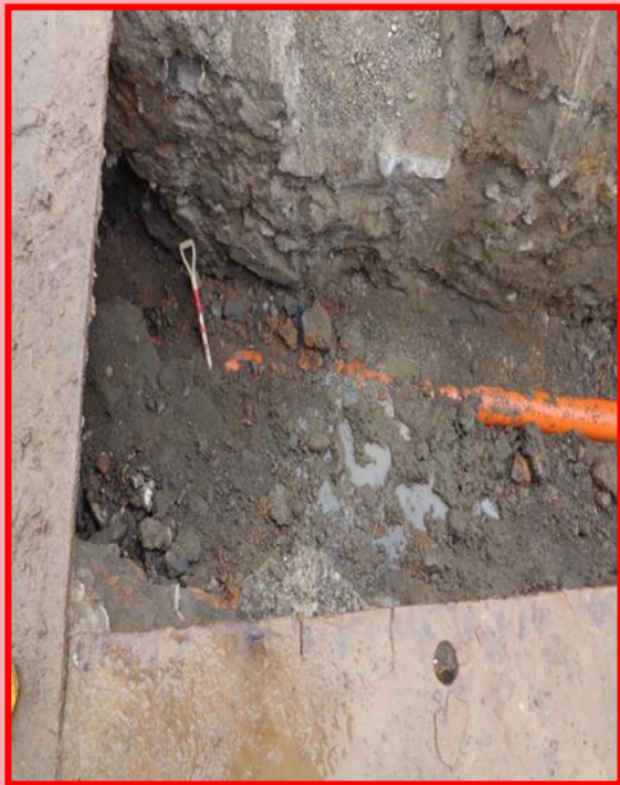
Before 未設置擋土支撐
