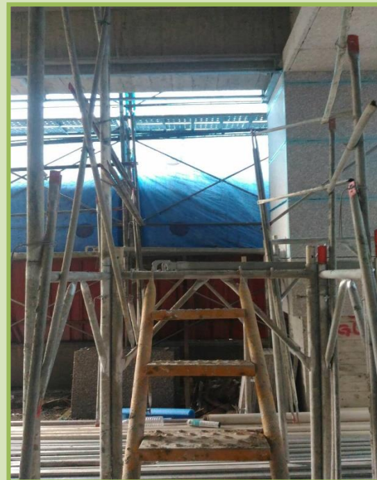
After 設置安全上下設備
