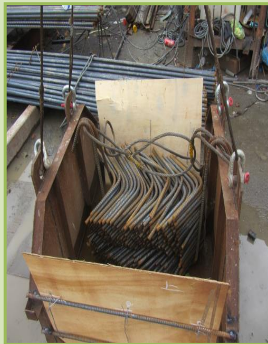
After 使用吊籃作業
