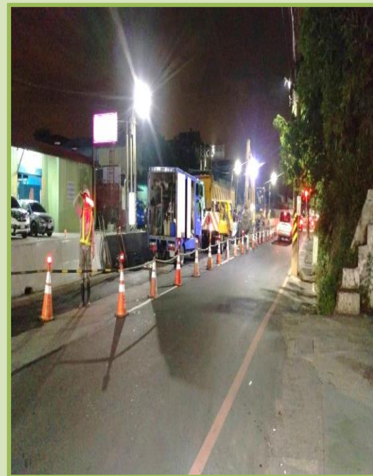
After 設置反光照明措施
