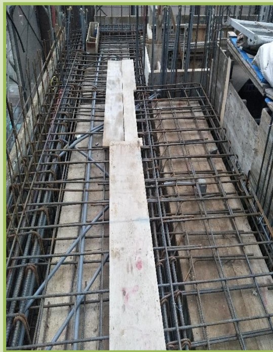
After 結構表面已鋪設木板
