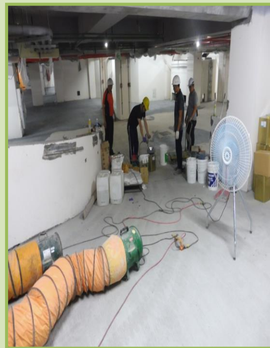
After 設置局部排氣裝置
