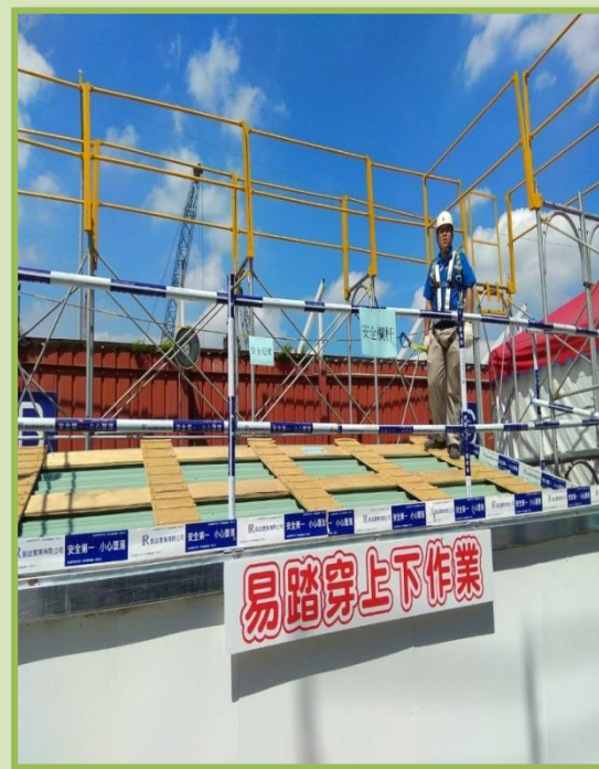
After 設置護欄及工作臺， 並使勞工使用安全帶
