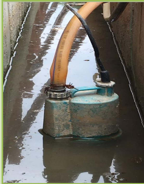
After 設置排水設備
