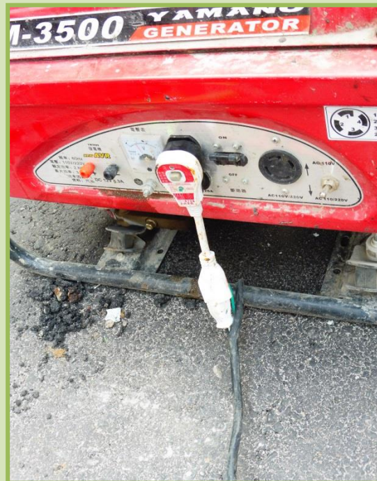
After 確實裝設漏電斷路器
