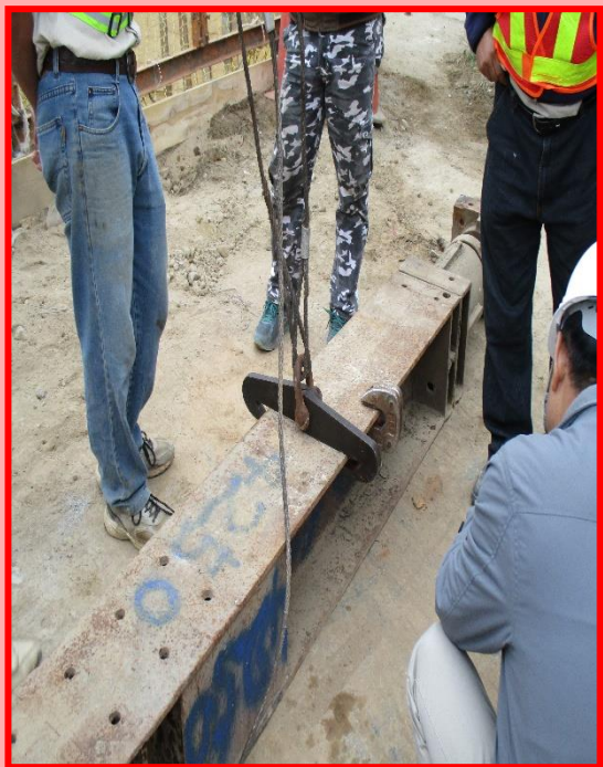
Before 未使吊運構架保持平穩
