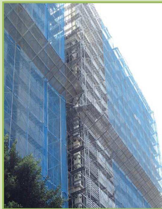
After 設置施工架設置斜籬
