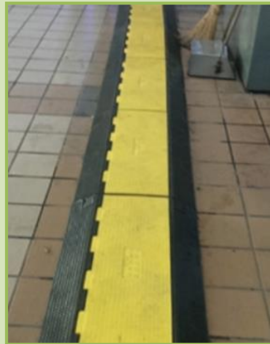
After 設置防止絕緣被覆損壞設施
