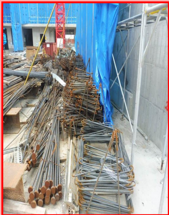
Before 使用鋼筋作為拉索支持物
