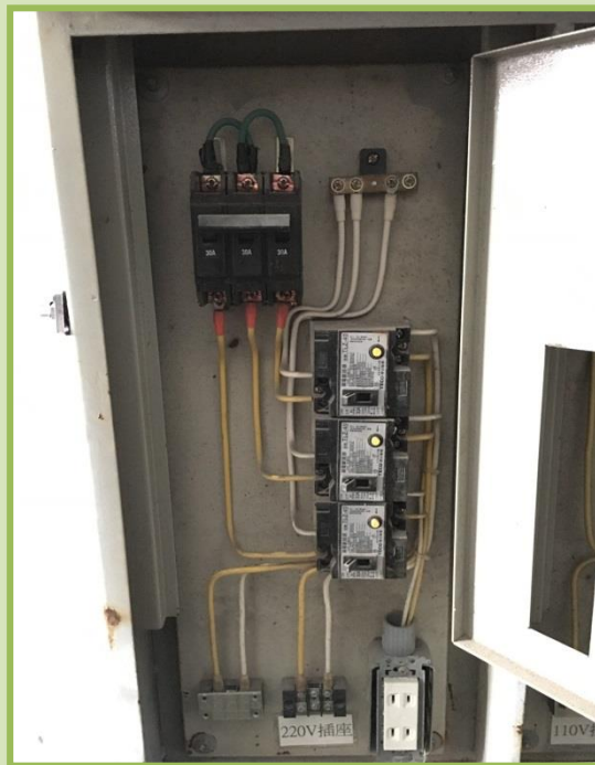
After 設置漏電斷路器
