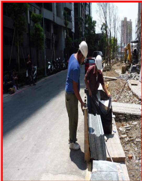
Before 未穿著反光帶之安全裝備
