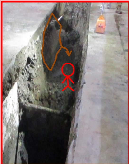
Before 未設置擋土支撐
