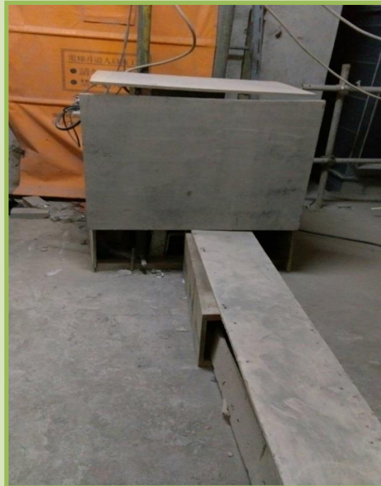
After 設置吊鎖通路防護設施
