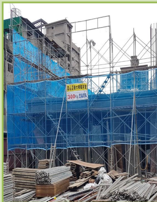
After 外牆施工架標示載重
