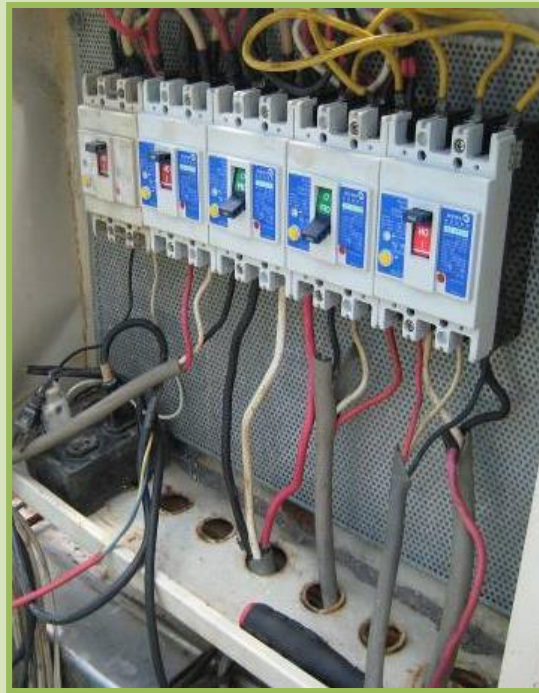
After 設置漏電斷路器
