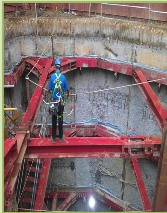
After 設置安全上下設備
