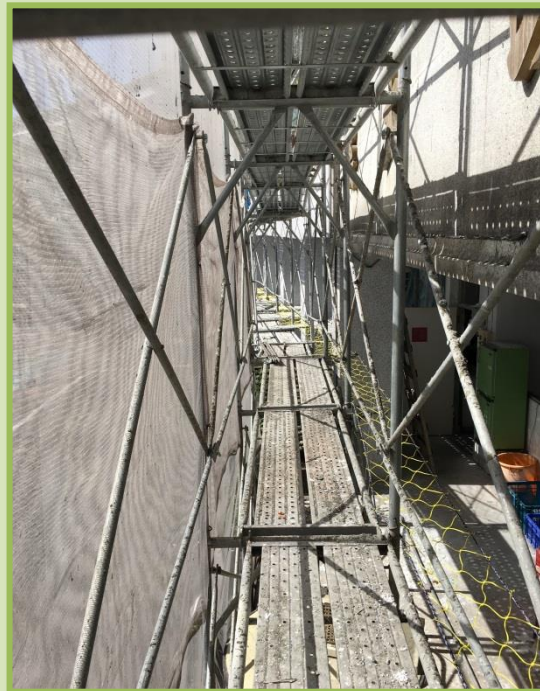
After 開口設置安全網
