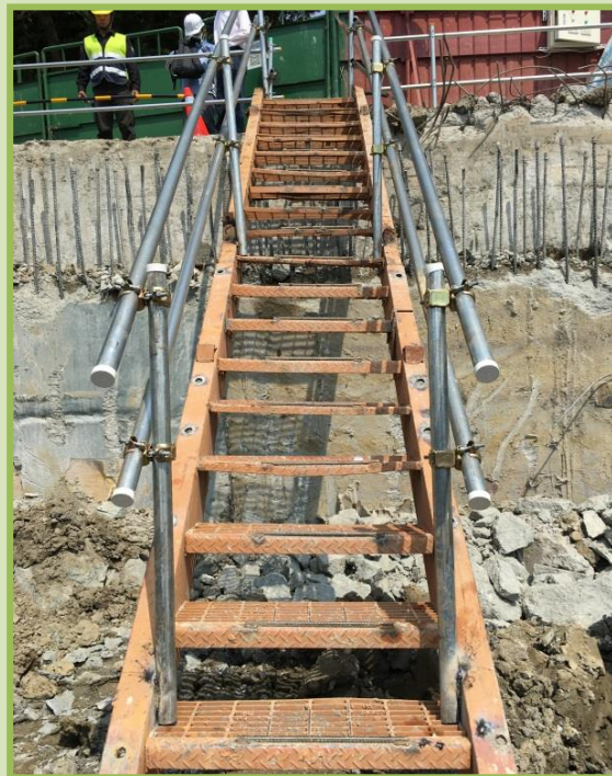
After 設置安全上下設備
