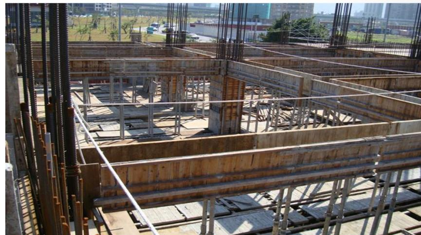
施作樑側模之模板作業，於該處設置護欄、護蓋或安全網等有困難時，可於柱筋設置安全母索供作業人員勾掛安全帶。
