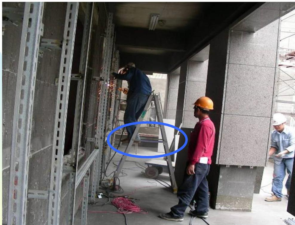
雇主對於使用之合梯，應具有堅固之構造；其材質不得有顯著之損傷、腐蝕等；梯腳與地面之角度應在75度以內，且兩梯腳間有金屬等硬質繫材扣牢，腳部有防滑絕緣腳座套；有安全防滑之梯面。（職業安全衛生設施規則第230條）
