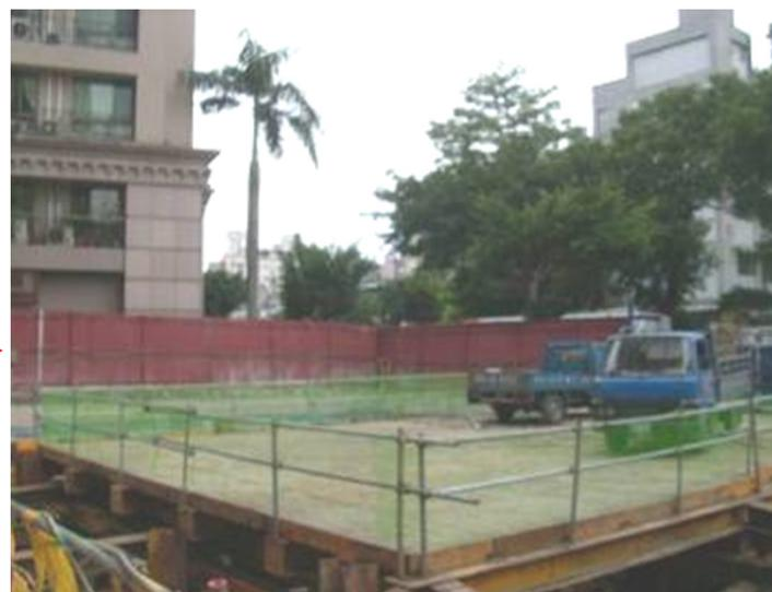
施工構臺周邊開口已設置**護欄**。
