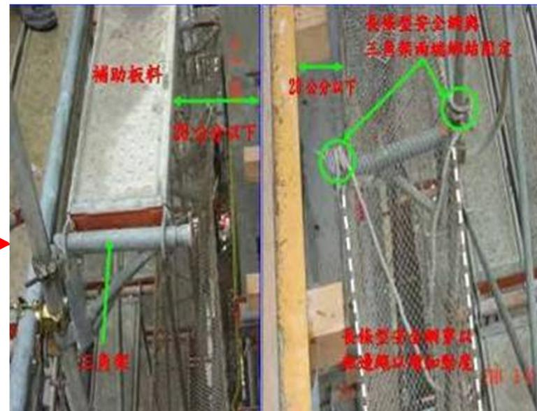
施工架與構造物間隙大於**20公分**的開口區域，未設置**補助板料**或**安全網**。(註：據統計，國民平均胸腔寬度為23cm)
