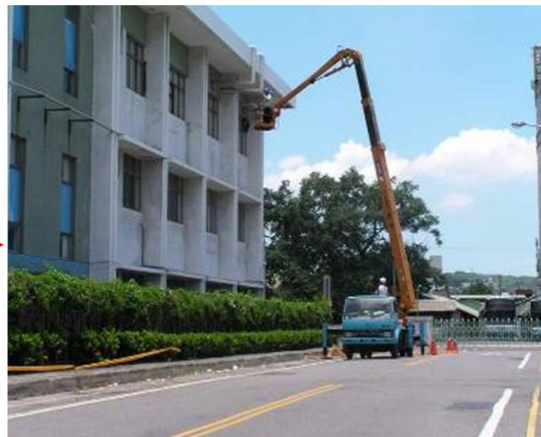
勞工已正確戴用**安全帽**，並使用**高空工作車**從事高處作業，且勞工已確實使用**安全帶**。
