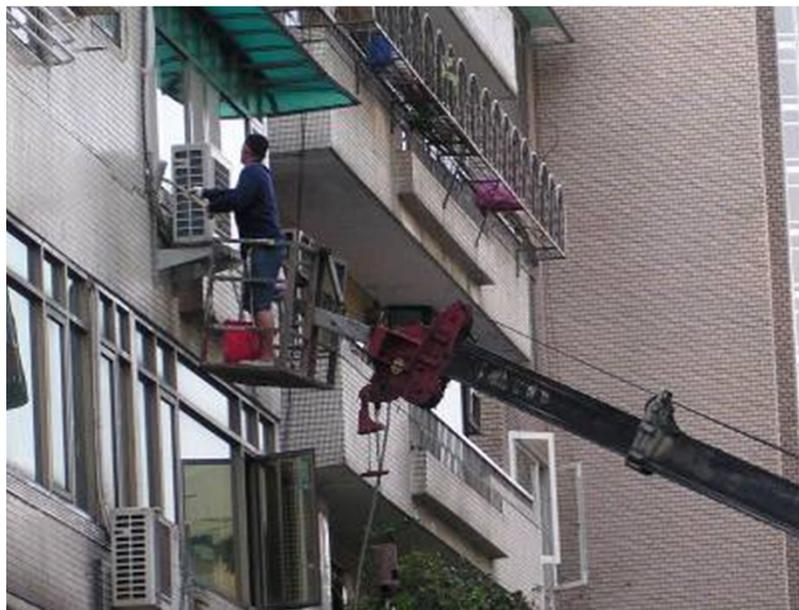
勞工未正確戴用**安全帽**，並使用**移動式起重機**從事高處作業，且勞工未確實使用**安全帶**。
