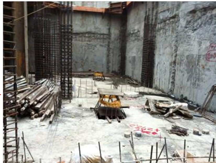
高度2公尺以上**中間柱臨時性開口**，其**護蓋**未依規定設置
