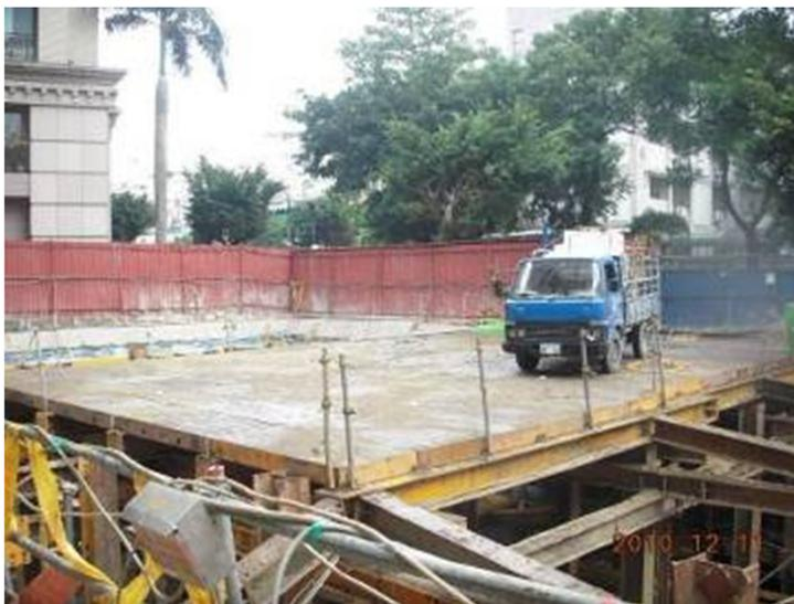
高度2公尺以上之**施工構臺**周邊開口，未設置**護欄**等防護設備。
