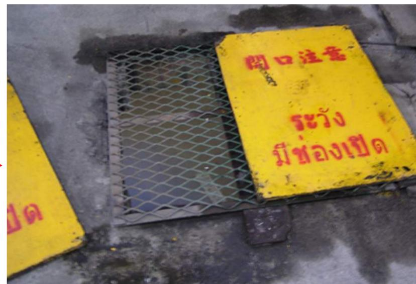
臨時性開口已設置符合規定之**護蓋**
