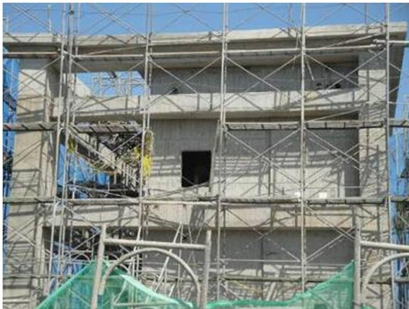
高度2公尺以上**兩側施工架開口**，未設置**交叉拉桿、下拉桿**等防護設備
