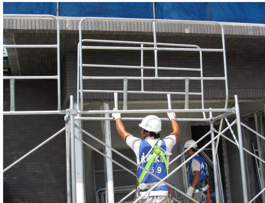
高度2公尺以上之**施工架組配或拆除作業**，勞工**未使用安全帶**。
