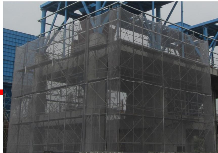
施工架兩側已設置**交叉拉桿、下拉桿**。
