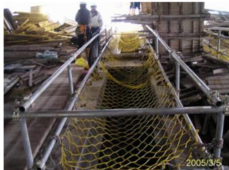
高度2公尺以上之**樓板開口**，未設置**護欄**、**安全網**等防護設備
