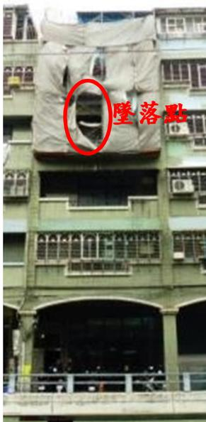
106年12月9日10時40分，靳○○僱勞工劉○○（男，63歲）於民宅4樓施工架上從事水泥砂漿粉刷作業，因該施工架外側未設置下拉桿等防墜設備，致劉員從第1層施工架外側開口墜落地上1樓地面（墜落高度約11公尺），經送新北市立聯合醫院三重院區急救仍死亡。
