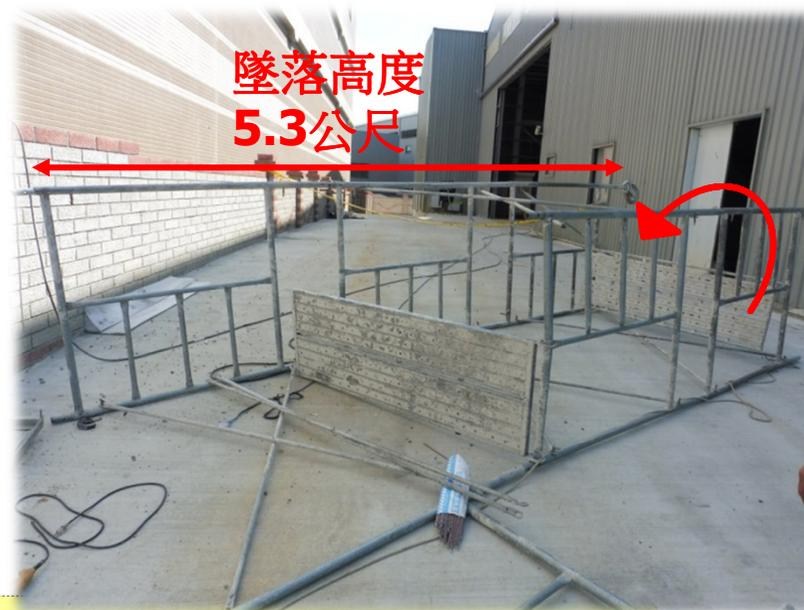
106年6月6日下午4時許，勞工鄭○○站立於第3層施工架上作業時，因施工架遭推移發生倒塌，造成鄭員連同倒塌施工架墜落地面（墜落高度約5.3公尺），經送林口長庚醫院當晚7時許不治死亡。
