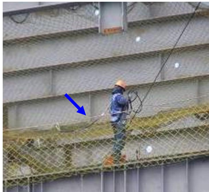
高度2公尺以上之鋼構作業，**未**依規定設置**安全母索**並使勞工確實使用**安全帶**。
