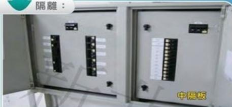
使帶電的電氣設備或線路與勞工有所區隔不易碰觸。如開關箱內電源線端子有接觸之虞者，以中隔板隔離。
