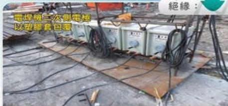
設備或電器帶電部分裸露，有使勞工接觸之虞時，應設置絕緣被覆如橡膠套、絕緣膠帶等加以保護及阻絕。
