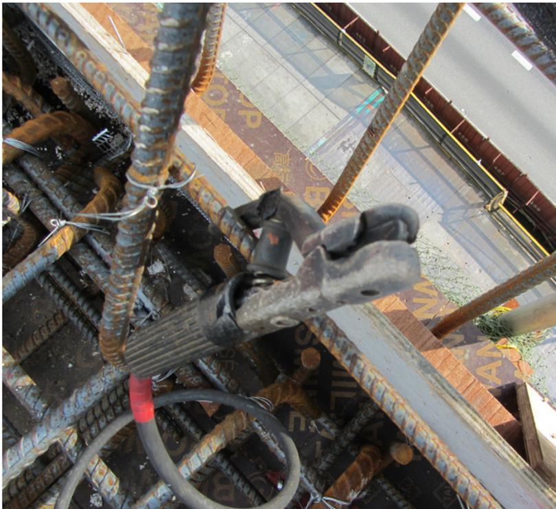
電焊作業之焊接柄部分絕緣被覆損壞
