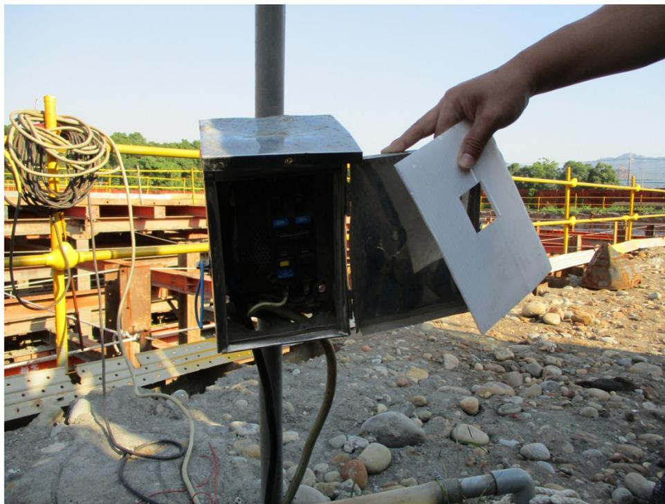
雇主對於使用對地電壓在**150伏特**以上移動式或攜帶式電動機具，或於含水或被其他導電度高之液體濕潤之潮濕場所、金屬板上或鋼架上等導電性良好場所使用移動式或攜帶式電動機具，為防止因漏電而生感電危害，應於各該電動機具之連接電路上設置適合其規格，具有高敏感度、高速型，能確實動作之防止感電用漏電斷路器。
