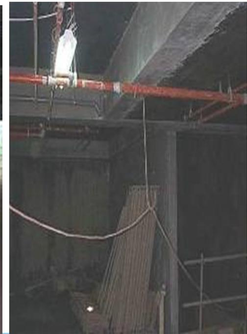
已使用架高器或以勾掛方式架高電線
