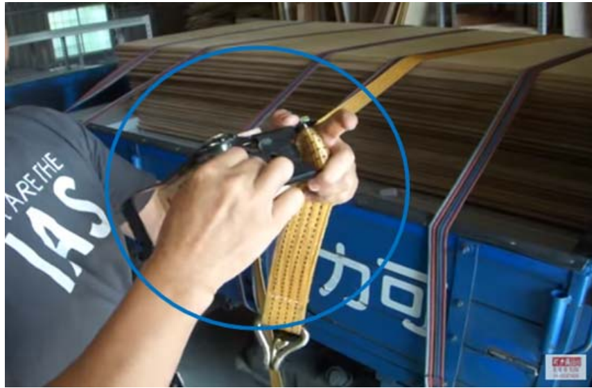
圖 2-1 廣告物運送時以手動拉緊器固定
