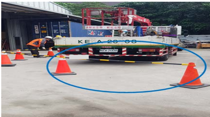
圖 2-10 以路錐隔離出作業危險警戒區域
