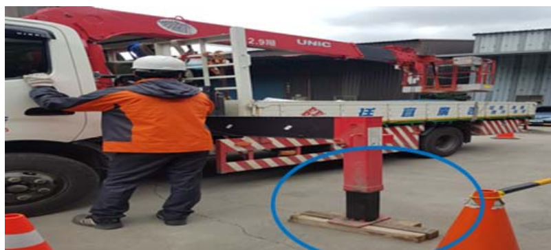
圖 2-11 外伸撐座下方鋪設鋼板或枕木
