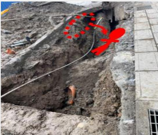
說明：從事露天開挖作業，其開挖深度超過1.5公尺，且使勞工進入開挖面作業，因未設置擋土支撐，致土石崩塌並壓擊陳員。
