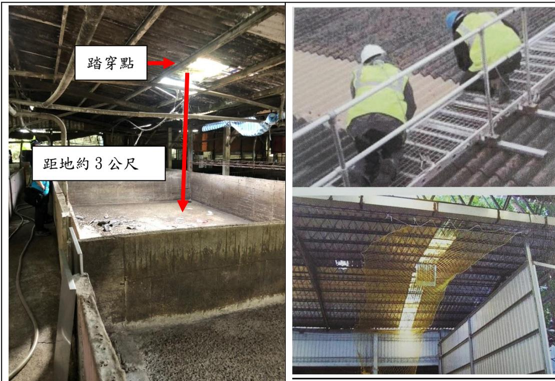
災害照片說明：江○○踏穿石棉瓦墜落死亡（墜落高度約3公尺）。
