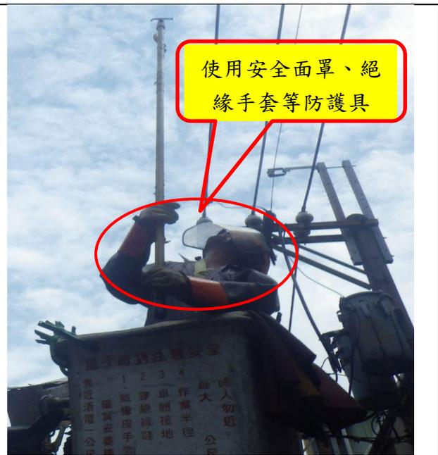
說明：從事高壓電路活線作業，應確實使用安全面罩、絕緣手套等防護具。
