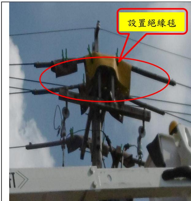
說明：從事高壓電路活線作業，應確實設置絕緣毯之絕緣用防護裝備。
