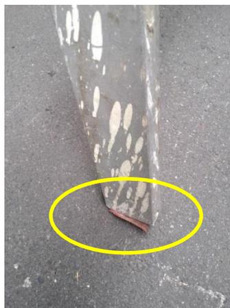
說明：現場移動梯未採取防止滑溜措施（梯腳止滑裝置已破損）。
