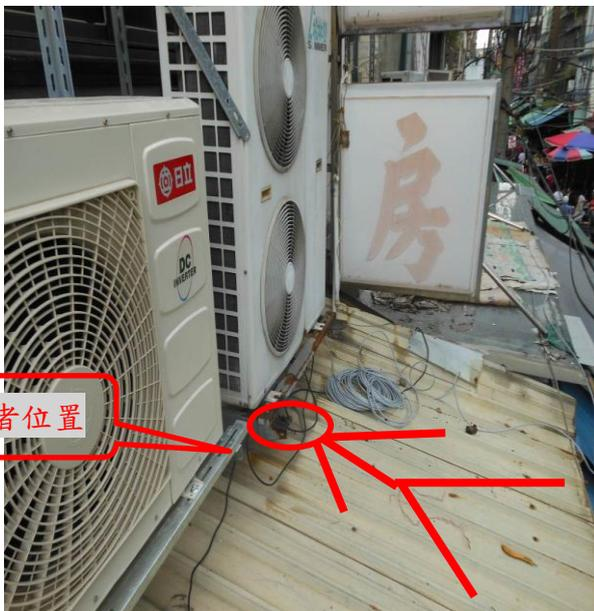
說明：從事電話線路整修作業，因接觸漏電冷氣室外機支架，發生感電致死。
