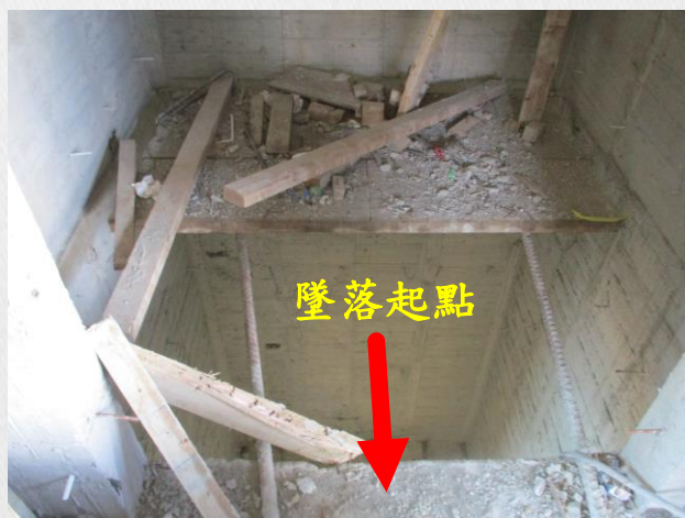
災害現場位置圖 （屋突一層N04電梯井）
