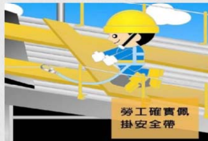
說明：屋頂作業穿戴安全帶。
