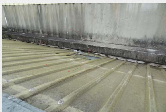
說明：現場踏穿位置
