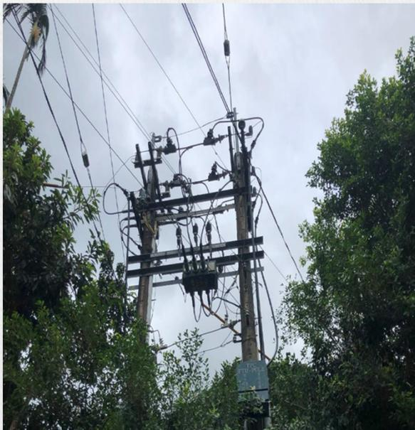
說明：未使勞工與帶電體保持規定之接近界限距離，亦未設置護圍、絕緣用防護裝備或採取移開該電路之措施。
