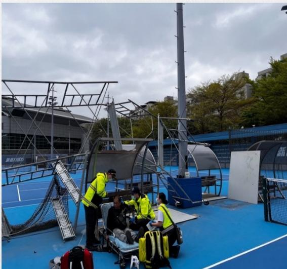
**說明：**移動式施工架未以斜撐材或其他相關設施支撐，且其施工架構件亦未以金屬附屬配件確實連接固定。
